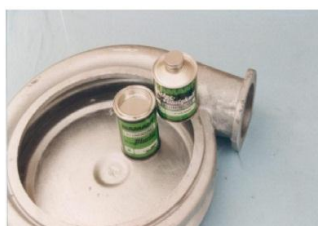
Ремонт усадочных раковин в корпусах насосов
